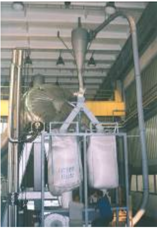
Abbildung 8. Vakuum-Kristallisationsanlage in Produktion
