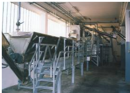
Abbildung 2. Waschwerk 1 t/h kompl. während der Montage
